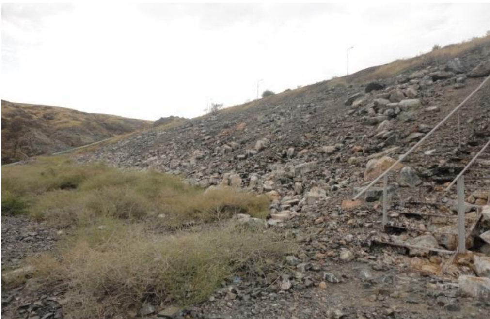
1 сурет - Күрті су қоймасының тас пен топырақтан үйіліп салынған бөгеті
