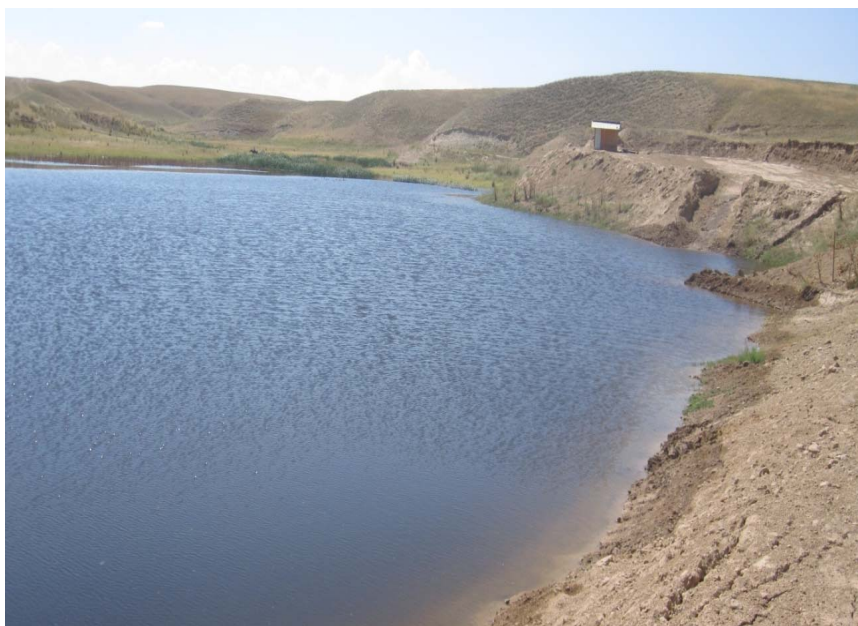
Рисунок 2- Общий вид водонакопительно- распределительного водоёма ТОО «Алшын»
