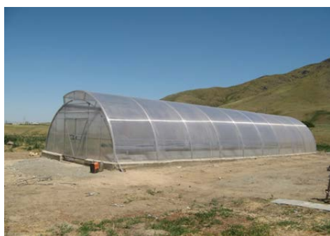
Рис.1 - Разработанная по проекту гелиосушилка-теплица и установленная в учебно-производственном хозяйстве КазНАУ «Саймасай» Енбекшиказахского района Алматинской области (отдельные фрагменты).
